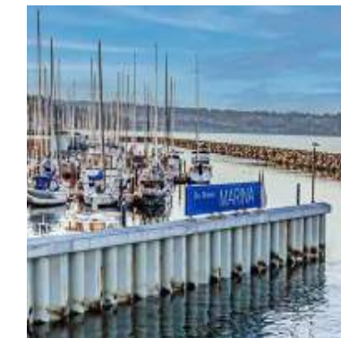
Des Moines Marina bulkhead
