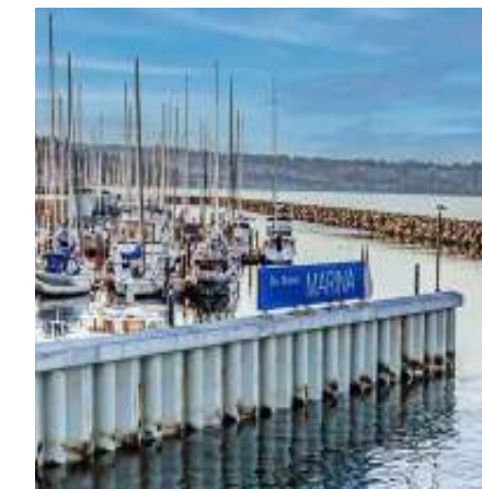
Des Moines Marina bulkhead
